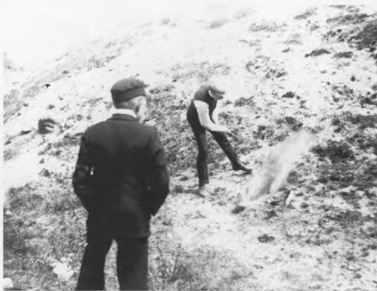
Bunker på Sandvikenbanan.
